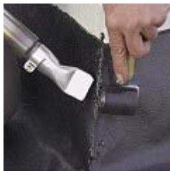
Bitumen schweißen
