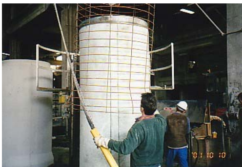
5. Einbringen der Bewehrung.
