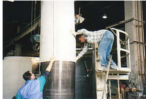
2. Aufziehen des Inliners auf den Kern.
