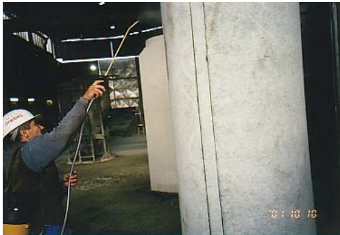
3. Befeuchten des Ankervliesstoffes.
