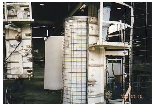
6. Schließen der Schalung.
